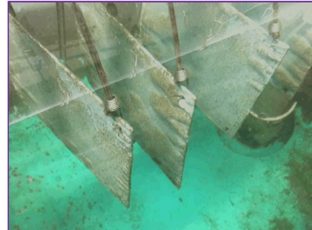
Edge failure, 6 months
