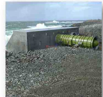
Source: Voith Hydro Wavegen
