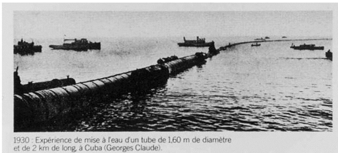
Figura 1. Instalación de Conversión de Energía Térmica Oceánica. Matanzas. Cuba 1930.
